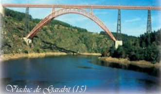
Viaduc de Garabit (15)
