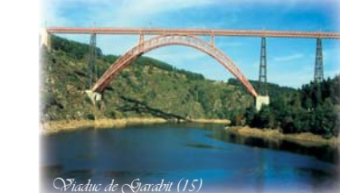
Viaduc de Garabit (15)
